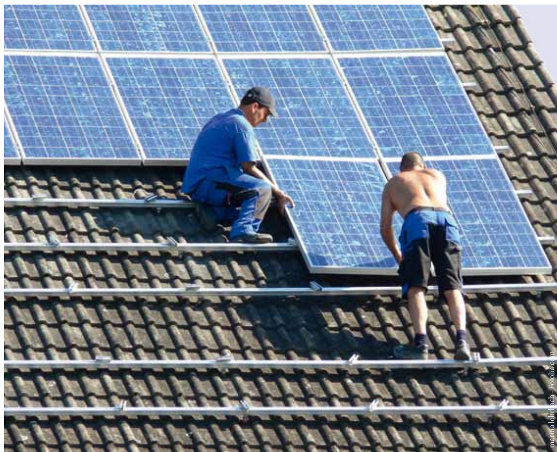
Errichtung einer Photovoltaikanlage
